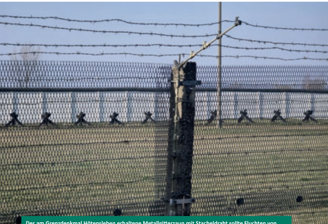
Der am Grenzdankmal Hötensleben erhaltene Metallgitterzaun mit Stacheldraht sollte Fluchten von DDR-Bürgern verhindern. Im Hintergrund: Fahrzeugsperren und die Grenzmauer aus Betonfertigteilen.
